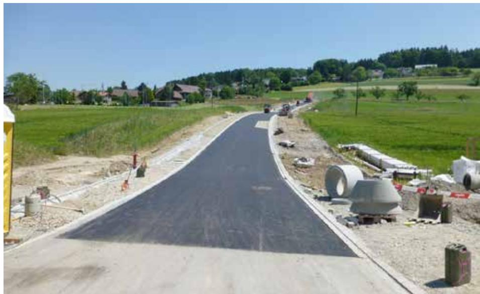
Die Erschliessung des unteren Teils des Quartierplangebiets, d.h. der Bau der Leitungen und Strassen sowie der Trafostation, wird diesen Sommer grössten teils abgeschlossen sein. Dann beginnen die Arbeiten an den privaten Bauvorhaben von 15 Mehrfamilienhäusern, und zwar mit dem Aushub der Tiefgarage. Jener Baustellenverkehr wird vorwiegend über die Heligenmattstrasse erfolgen.
