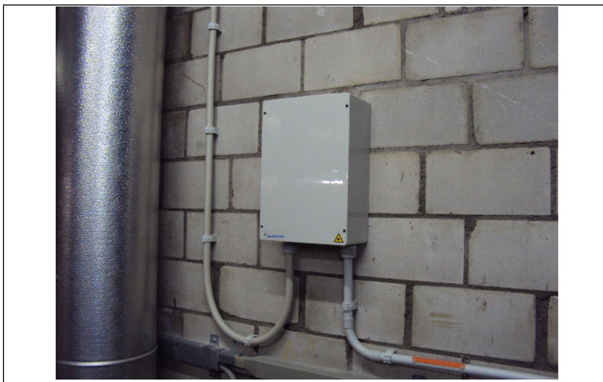
Abbildung 4 Erhältliche BEP Grössen: HAK O 5; HAK O 16; HAK O 24; HAK O 36; HAK O 48
